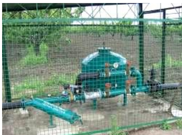
Рисунок 3. Песчано-гравийные фильтры различной конструкции
