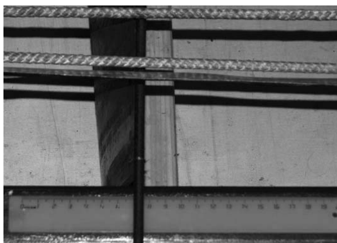
Рисунок 5. Способ контроля положения разделительных щитков
